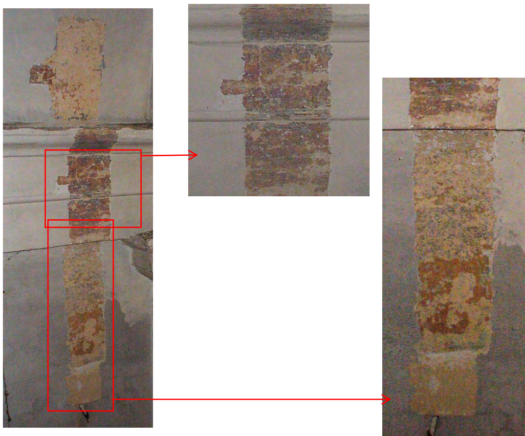
Foto 12: saggio 9 stratigrafia sovrapposizioni tra volta e parete
