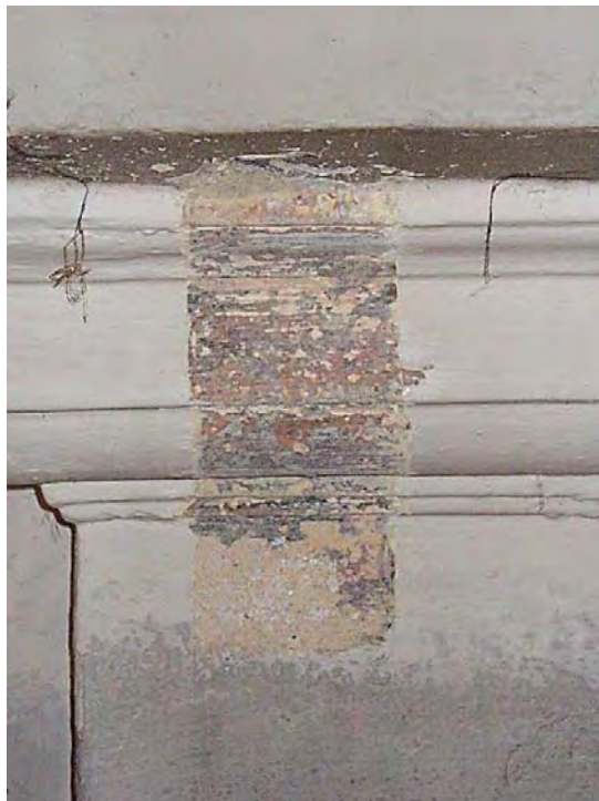
Foto 13: saggio 10 coloritura rosso ocre sul capitello e sulla lesena senza differenziazione cromatica ocre che copre la tinta gialla data su tutte le superfici.
