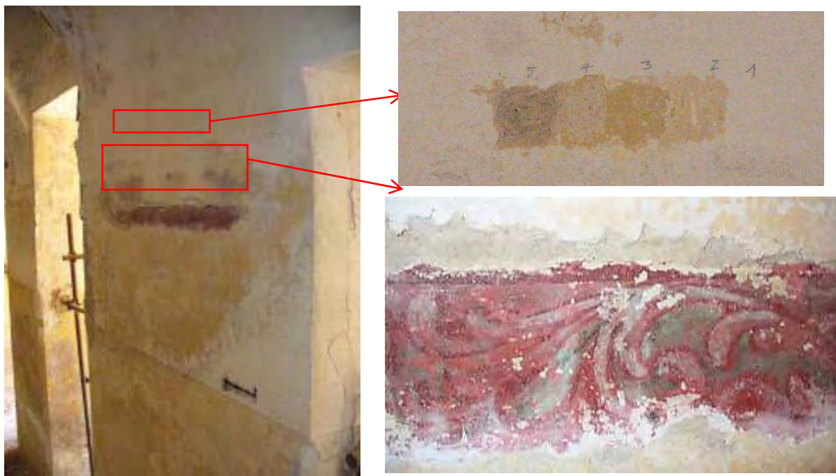
Foto 16: saggi 13 e 14 stratigrafia dell'intonaco sovrammesso alla decorazione; particolare della decorazione a secco al di sotto di strati sovrammessi di scialbo e intonaco.
