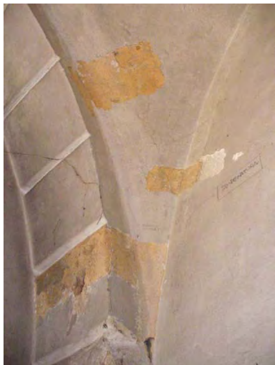
Foto 13: saggio 10 coloritura rosso ocre sul capitello e sulla lesena senza differenziazione cromatica ocre che copre la tinta gialla data su tutte le superfici.
