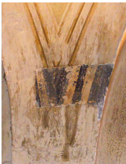
Foto 20: saggio 17 , descialbo peduccio della volta
