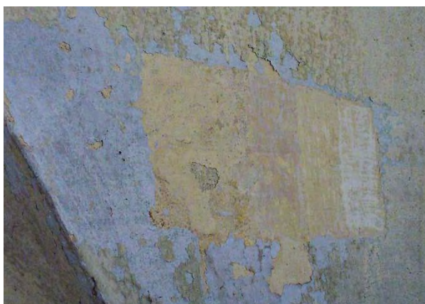
Foto 22: ampliamento stratigrafia tinteggiatura murale
