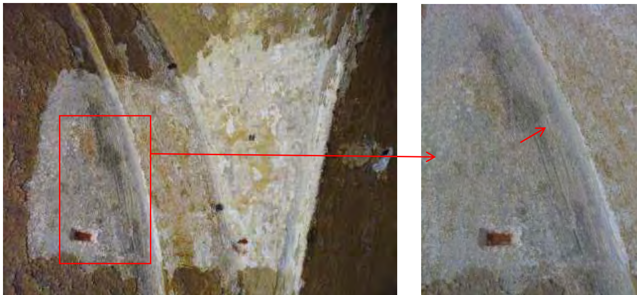
Foto 8: saggio 7 , intonaci degradati con evidenza di sovrapposizione degli intonaci
