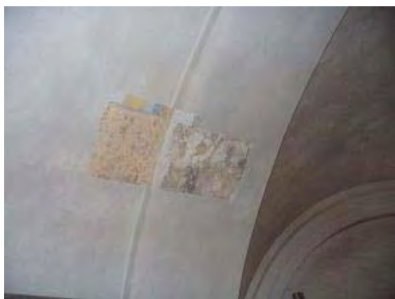
Foto 9, 10: tasselli eseguiti in volta e sulle pareti dell'ambiente ovale.
