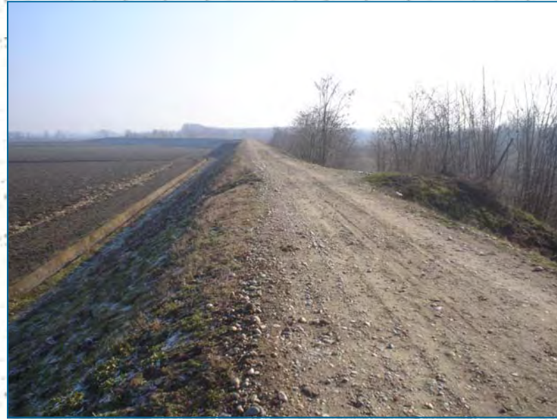
ARGINE IN SPONDA SINISTRA (foto 1) L'argine divide la ZPS dalle risaie circostanti poste a quota -7,50 m.
