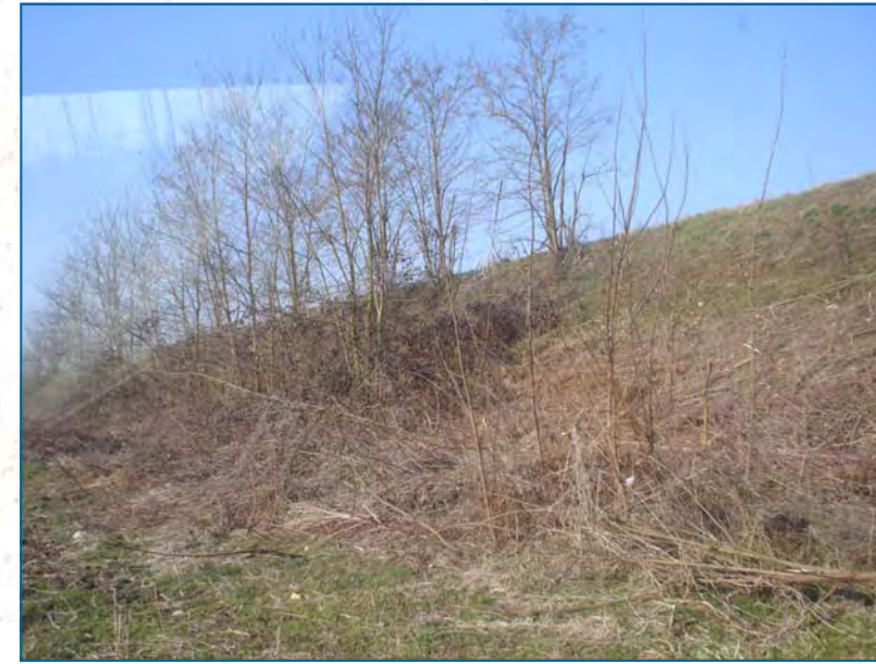
ARGINE IN SPONDA SINISTRA (foto 3) La scarpata dell'argine verso la ZPS
