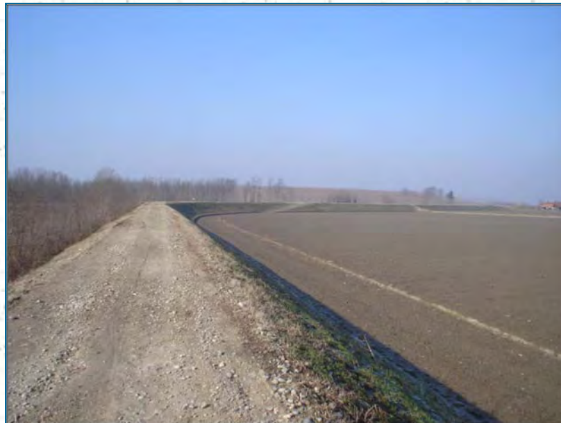
ARGINE IN SPONDA SINISTRA (foto 2)
