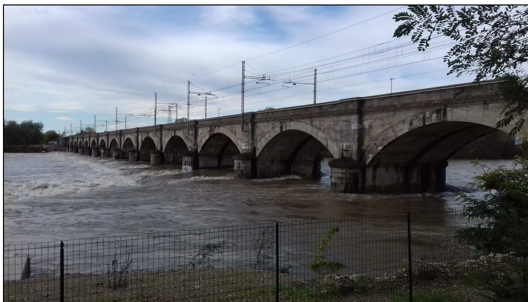
foto: Ponte ferroviario sul fiume Sesia nella piena del 30 ottobre 2018
