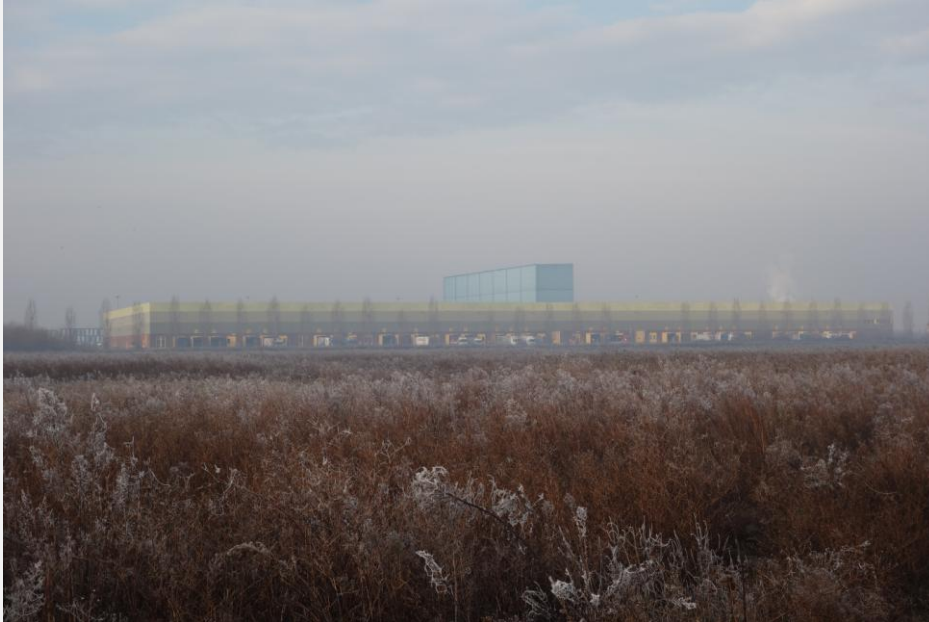
Attività logistiche PIP a S della Roggia Molinara
