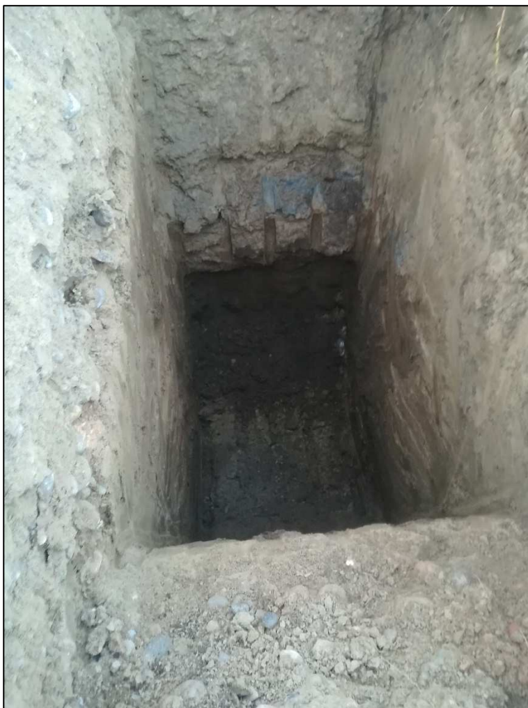
Foto 13 e 14 – Scavo geognostico SG7
