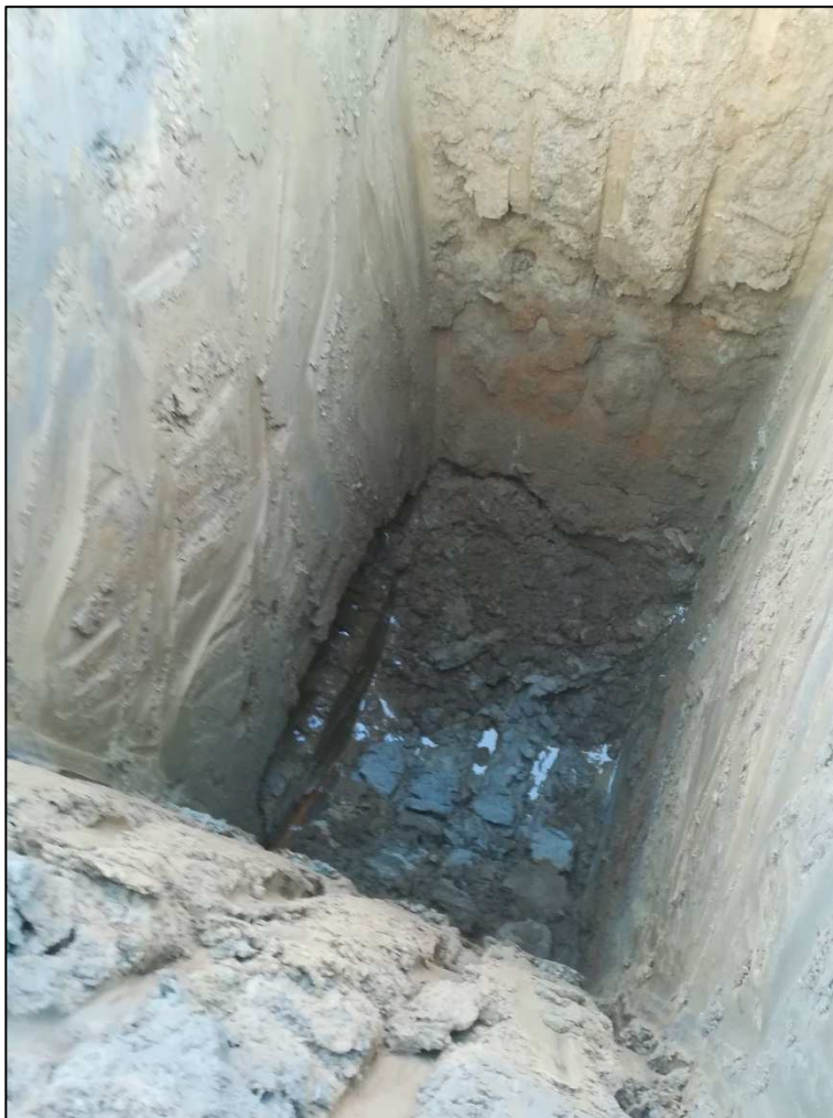
Foto 11 e 12 – Scavo geognostico SG6
