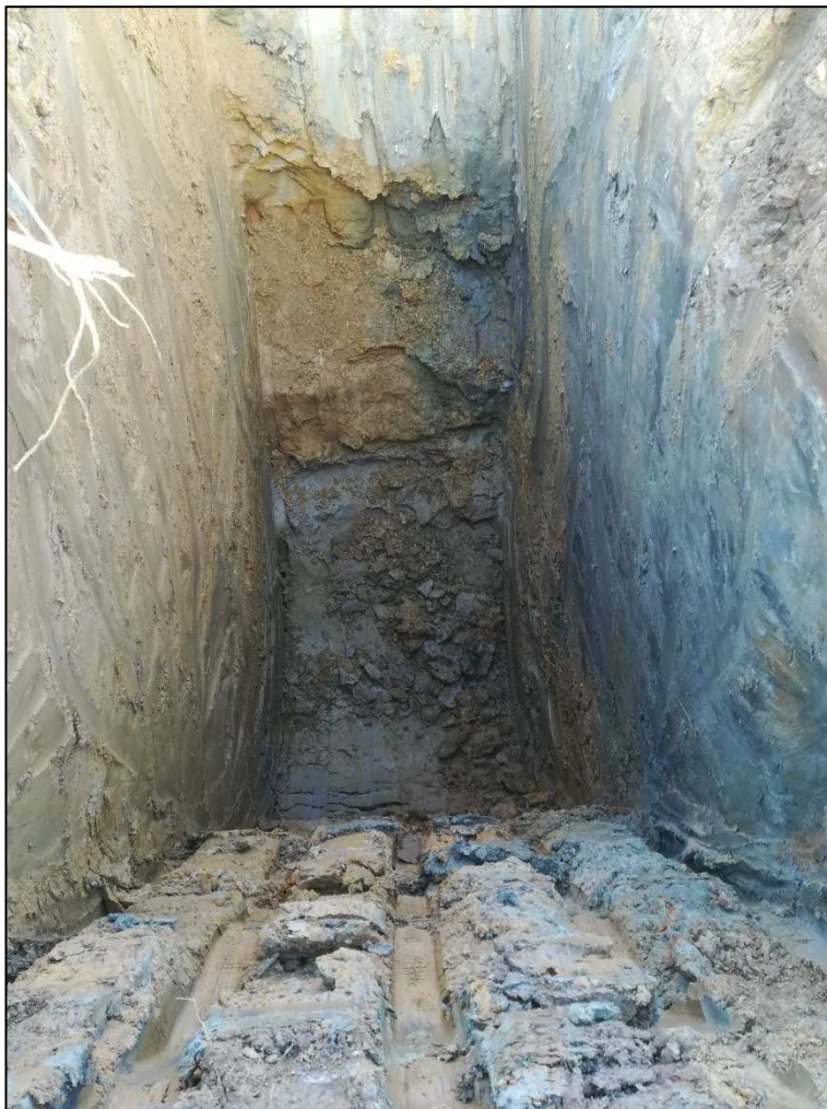
Foto 9 e 10 – Scavo geognostico SG5
